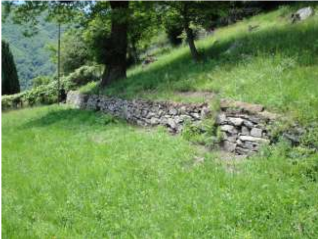
...und nachher: wiederaufgebaute Trockenmauerchen.
